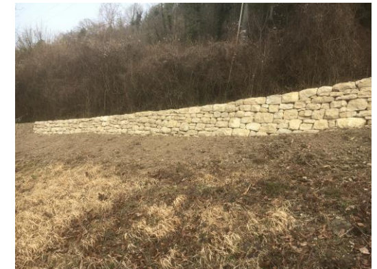
Neue Bruchsteinmauer im Eichengraben
